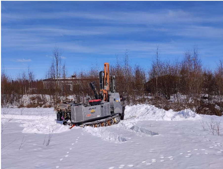
Kuva 8. Tutkimuspiste KP6. Kuvaussuunta pohjoiseen.
