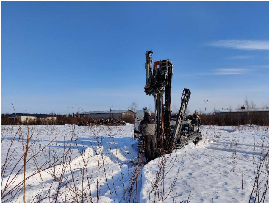
Kuva 13. Tutkimuspiste KP11. Kuvaussuunta pohjoiseen.
